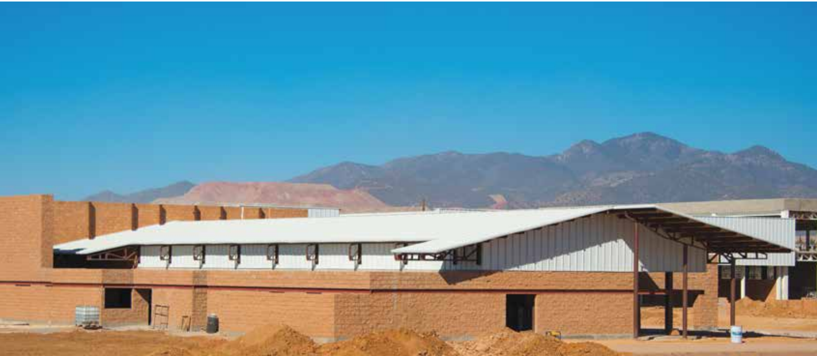
El nuevo Centro de Servicios que estamos construyendo en Cananea albergará una plaza comercial con cuatro salas de cine, boliche, supermercado, diversos comercios, una alberca semi-olímpica con gimnasio. En este mismo espacio se está construyendo un hospital regional por medio de una inversión tripartita con el Gobierno Federal y Estatal. Proyecto de Centro de Servicios y Entretenimiento Nuevo Cananea, Sonora.
