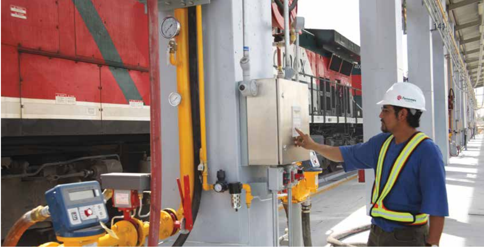
Supervisando la Zona de abasto. Torreón, Coahuila.
