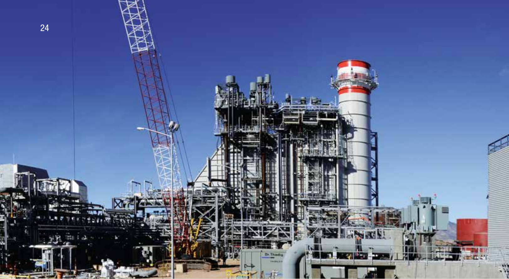
Fase final de la construcción de nuestra primera Planta de Energía, que forma parte del programa de cuatro Plantas que generarán 1,000 MW. Planta de Energía I de ciclo combinado de 250 MW. La Caridad, Sonora.
